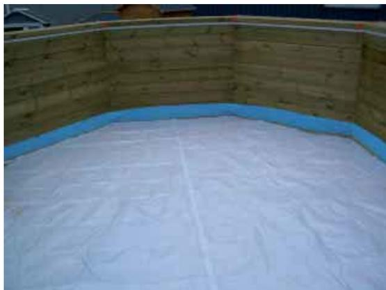
Installer ensuite le liner dans la piscine. La température extérieure doit être entre 15 et 25°C afin que la matière soit souple. Avec des températures plus fraîches, le liner sera rigide et rétracté, au-dessus de 25°C le liner se détendra et risque de faire des plis. Si la météo n'est pas clémente, entreposer le liner dans une pièce chauffée avant la pose.
